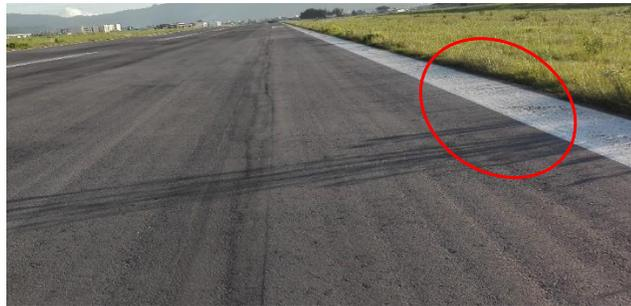
Imagen 7.1.3 Fisura de Borde de una pista
