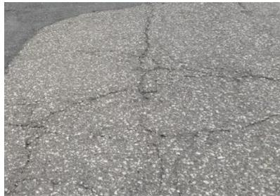
Imagen 7.1.4 Fisura en Bloque de la pista
