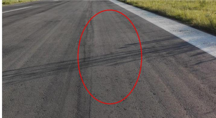
Imagen 4.3.1.1 Ondulación en una pista
