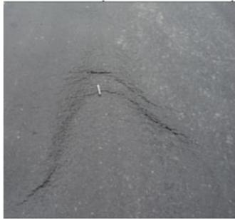
Imagen 7.1.6 Fisuración por deslizamiento
