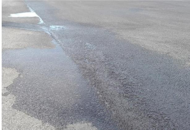
Imagen 7.2.3 Hundimiento en una pista
