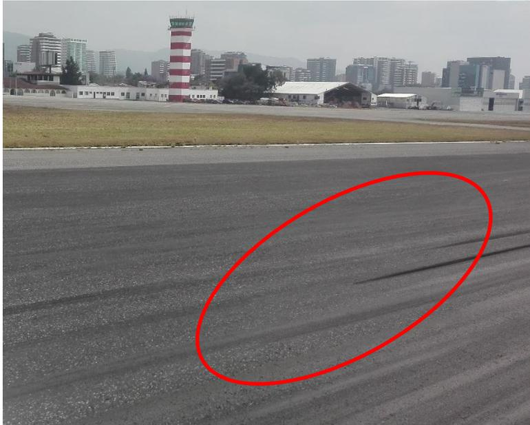
Imagen 7.2.4 Ahuellamiento en una pista
